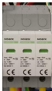
Figura 6 - Scaricatore di sovratensione SPD
