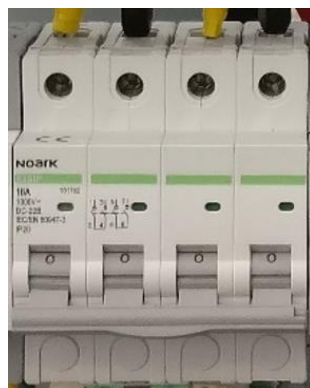
Figura 5 - Interruttore automatico magnetotermico: posizione di OFF - Spento
